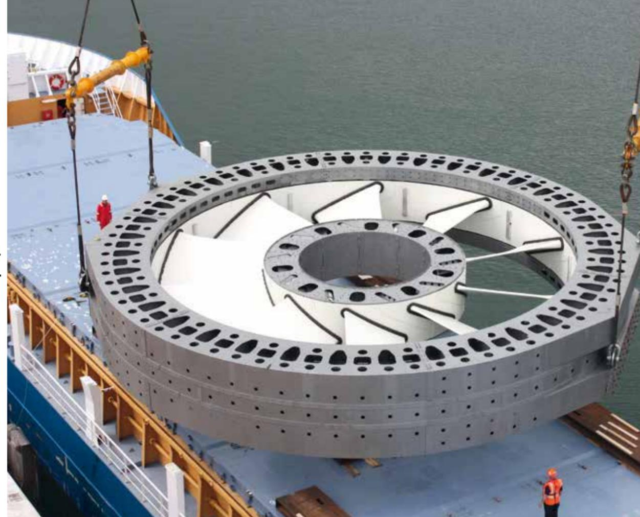
Une turbine hydrolienne sera prochainement mise à l'eau sur le site de Paimpol-Bréhat.
